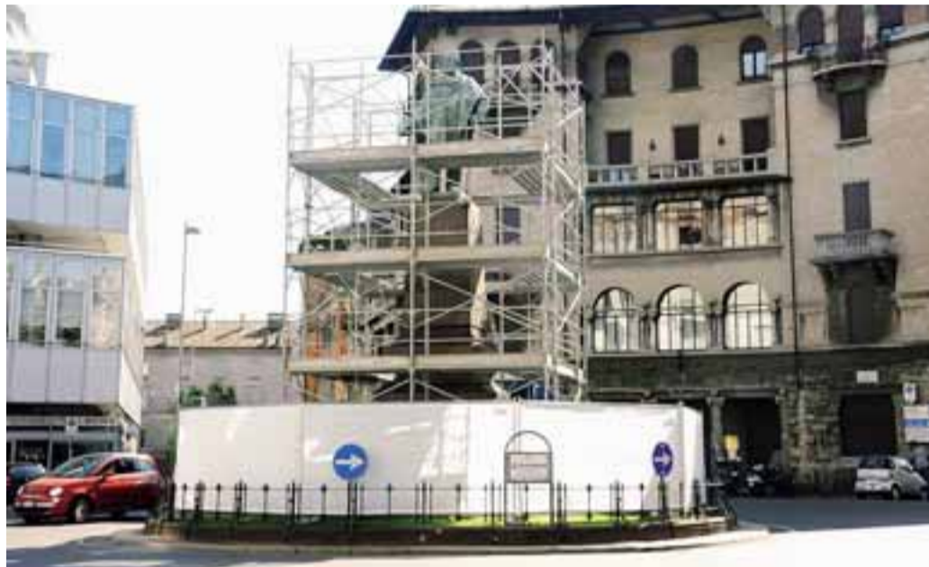
Già cominciati i lavori di restauro al monumento a Garibaldi alla Rotonda dei Mille FOTO BEDOLIS
