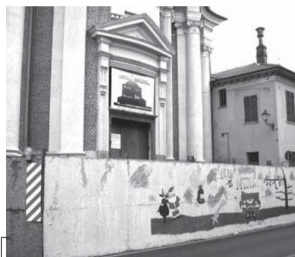
Un particolare del cantiere
